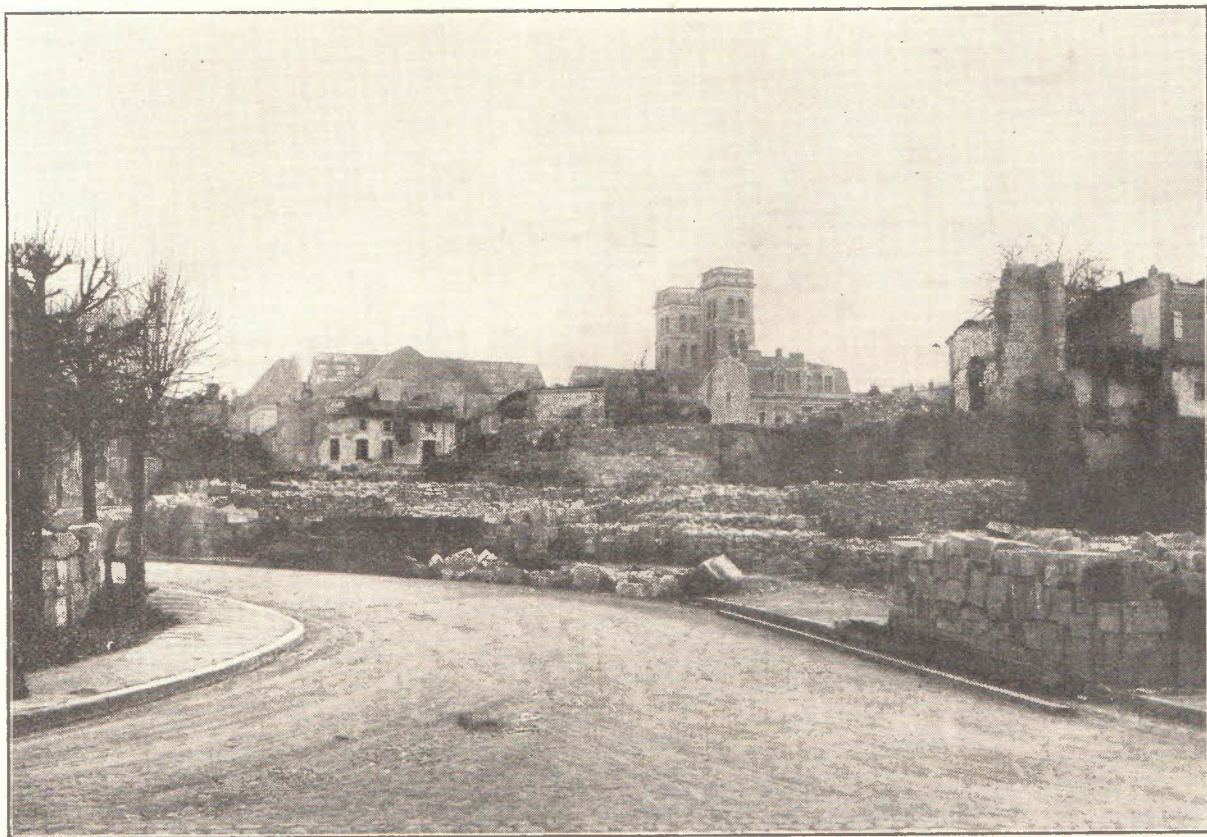
Verdun-sur-Meuse (14 février 1921). Place d'Armes et rue de la Belle-Vierge déblayées. (Collection de la Préfecture de la Meuse).
