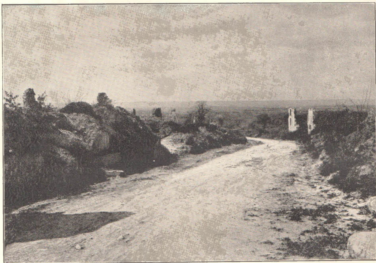
Montfaucon (Meuse). Ruines conservées comme vestiges de guerre. (Collection de la Préfecture de la Meuse).
